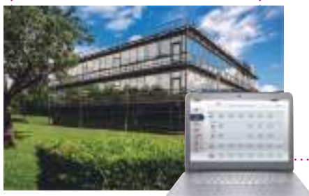
Sistema de gestão de edifícios (BMS)
