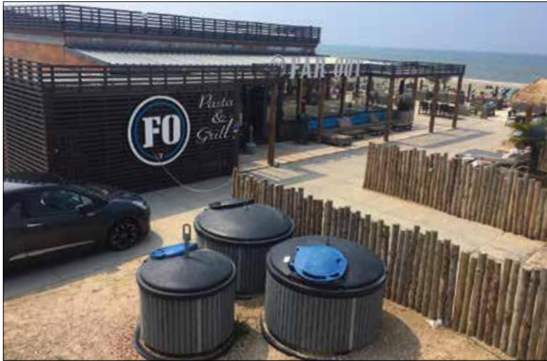
Contentores com divisórias no Beachclub Far Out em Zandvoort (Países Baixos). Os clubes de praia são obrigados a desmontar os equipamentos após a época balnear para que as praias fiquem vazias. Para este tipo de Tiërso, a tampa pode ser removida e a parte enterrada é tapada com uma placa de cobertura.
